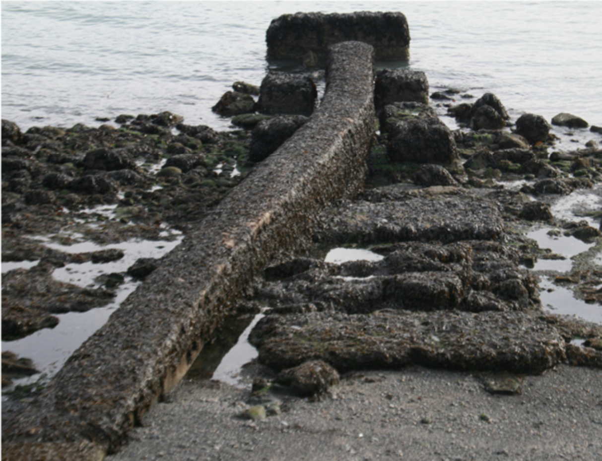
Mynd 3. Frárennislístockkur og bryggjuleifar. Nyrstu stöplarnir eru horfnir, en sökkulleifar eru enn sjáanlegar.
